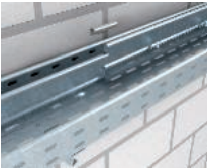
Válaszfal szerelése csavaros kötéssel TSG 60 válaszfal csavaros rögzítése M6x12-es félgömbfejű csavarokkal. A válaszfal egyszerűen a toldáspont fölé helyezhető, és a TSGV válaszfal-összekötő segítségével csavarok nélkül rögzíthető.
