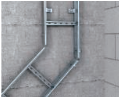
Kábeltrák sarokösszekötése Flexibilis kábelhágcsó-iránytörés készítése LWVG típusú sarokösszekötővel.
