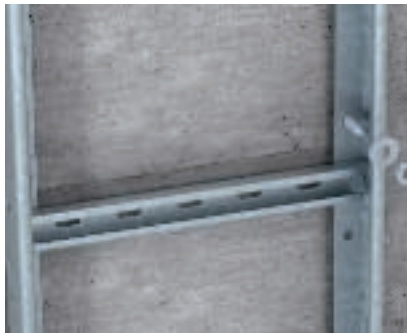
Felszerelés közvetlenül a falra LG és SSL kábelhágcsók rögzítése közvetlenül a falra horgonycsapokkal.
