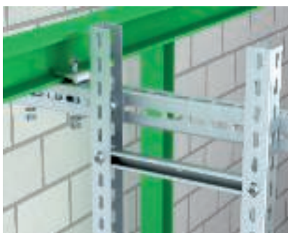
Kábelhágcsó szerelése acélszerkezetre Az SLM 50 típusú, nehéz kivitelű kábelhágcsók felszerelése U-profilból kialakított konzolos tartókkal acélszerkezetre.
