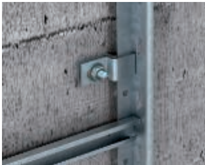
Könnyű kivitelű kábelhágcsó falra rögzítése Az SLL 45 típusú, könnyű kivitelű kábelhágcsó falra rögzítése WB 30 75 FT típusú falikengyelrel.
