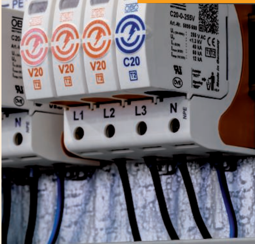
Túlfeszültség-védelem Energiaellátás 2. típusú SPD.
