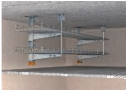
Kétszintes földmfüggesztés, egy oldalon elhelyezett konzolokkal
