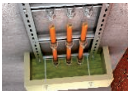
Hatásos alátámasztás ZSE90 húzásmentesítővel
