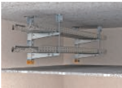
Kétszintes földmüfűggesztés, egy oldalán elhelyezett konzolokkal
