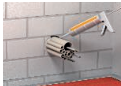
A hézagok kitöltése DSX masszával
