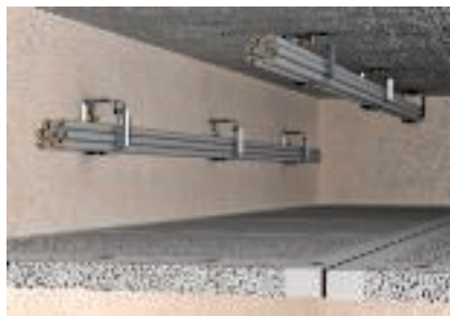
Fali és mennyezeti szerelés tűzvédelmi álmennyezet felett
