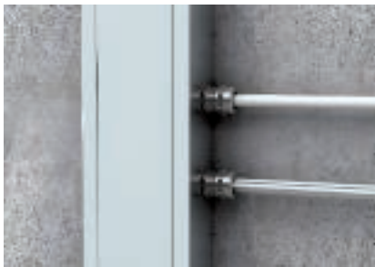
Kábel kiállítás V-TEC-tömszelencékkel, egyedi vagy csoportos tömítőgyűrűvel
