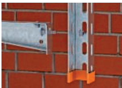
A konzol rögzítése az oszlopon, félgömbfejű csavarral
