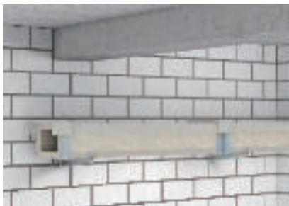
Fali szerelés I-csatornaként
