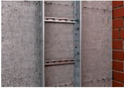
Kábelhágcsó közvetlen szerelése a tömör falra
