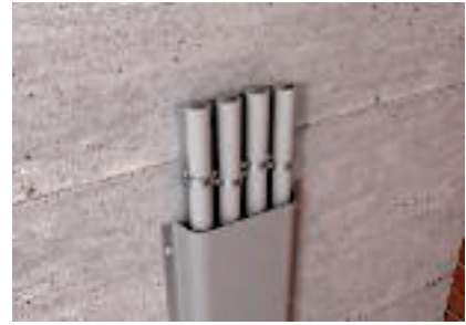
A bandázs rögzítése fém sínekkel, bilincses kábelrögzítés esetén
