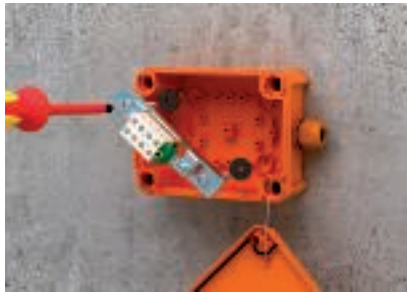
Szerelés tűzvédelmi dübellel a kengyelen és a FireBox alján keresztül
