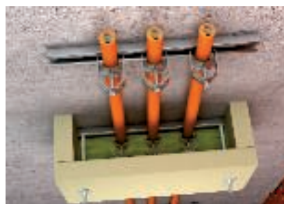
Hatásos alátámasztás ZSE90 húzásmentesítővel
