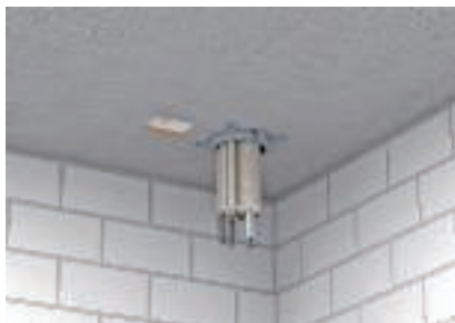
Szerelés a födém alsó részén, fémdübelekkel
