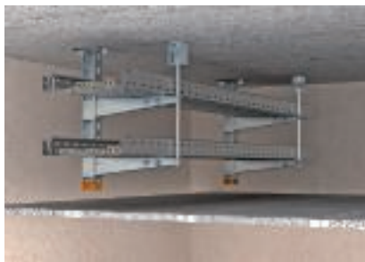
Kétszintes földműfüggesztés, egy oldalon elhelyezett konzolokkal
