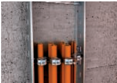
Kábelek rögzítése egyenként vagy csoportosan, kengyeles bilincsekkel
