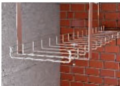
A rácsos kábeltálca rögzítése kapocssal és félgömbfejű csavarral
