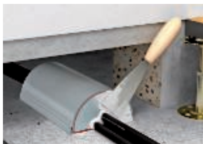
A felület füstgáz tömör lezárása ASX-szel
