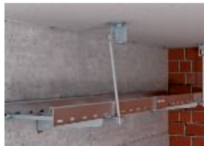
A menetes rúd rögzítése a tűzvédelmi földemkengyellel
