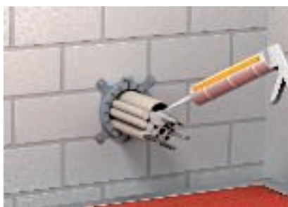
A csővégek kitöltése DSX masszával
