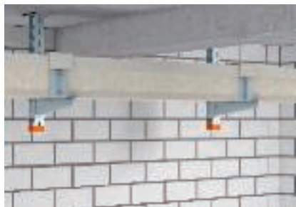
Függesztett mennyezeti szerelés, I-csatornaként
