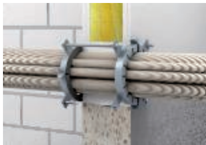
A csőmandzsetták kétoldali elhelyezése, fali szerelésnél
