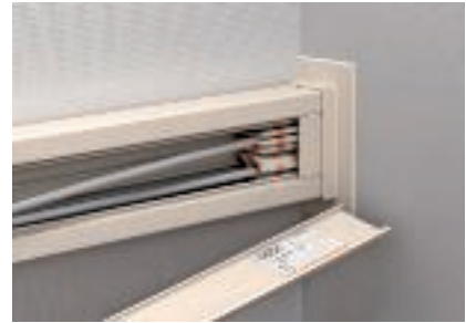
Jelölés elhelyezése a csatorna belső részén
