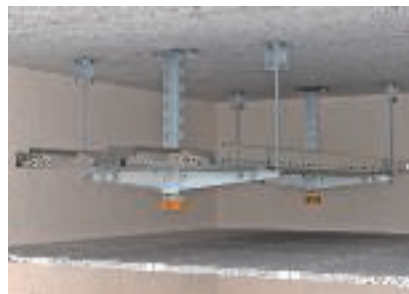
Kétszintes földmüfűggesztés kétoldali konzolelhelyezéssel
