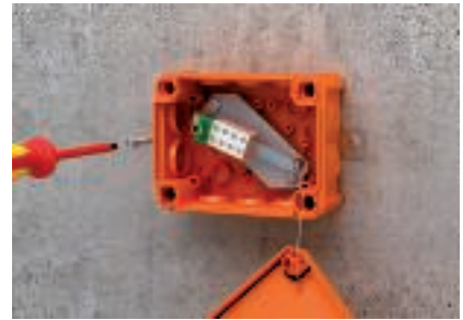
Gyors fedélszerelés a csavarok 90°-os elfordításával
