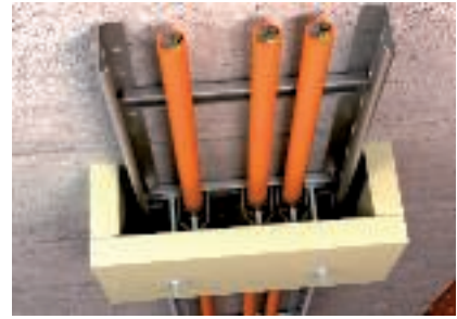
A húzásmentesítő szerelése kábelhágcsón
