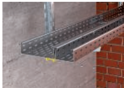
2 kábeltálca egymás melletti elhelyezése egy konzolon
