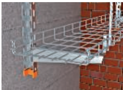
A rácsos kábeltálca csavarmentes felerősítése a konzolra.
