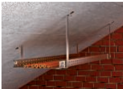
Szerelés dőlt mennyezetre, egyedileg igazított födémkengyellel
