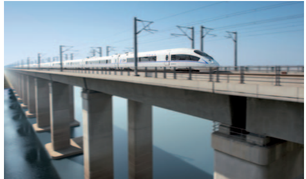
BETONJAVÍTÁS ÉS SZERKEZETMEGERŐSÍTÉS
